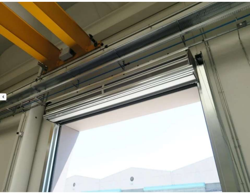
PORTA EM POSIÇÃO ABERTA, VISTA INTERIOR
