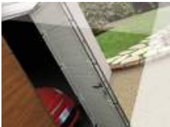
Porta de serviço
